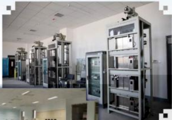
智能电梯安装调试 维护训练场所
